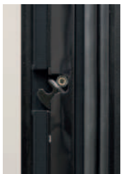
Der Verschluss mit pferdekopfförmiger Verriegelung im Rahmen
